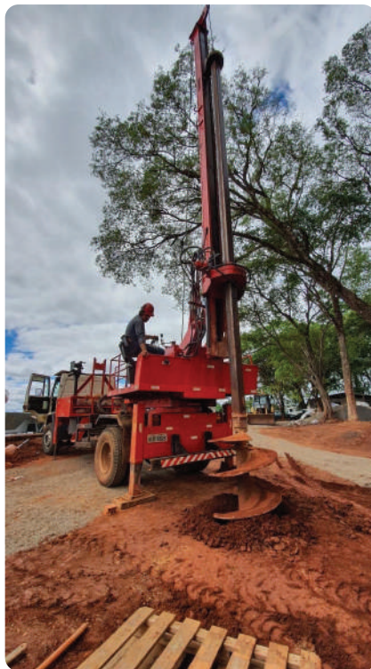
Figura 7.54 – Equipamentos perfuratriz podem realizar a escavação do fuste.
