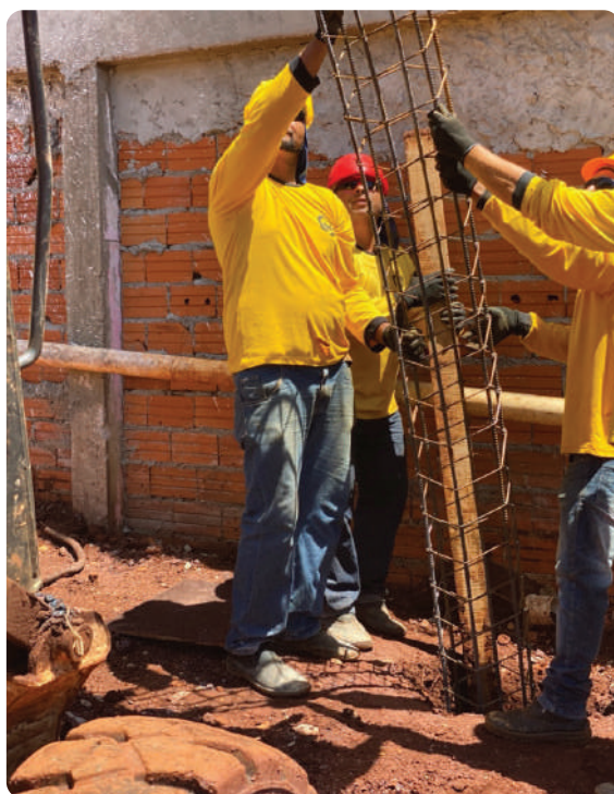
Figura 7.7 – Inserção da armadura na estaca escavada.
