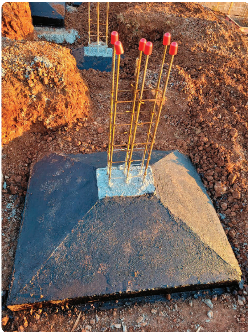
Figura 6.1 – Sapata de fundação.
