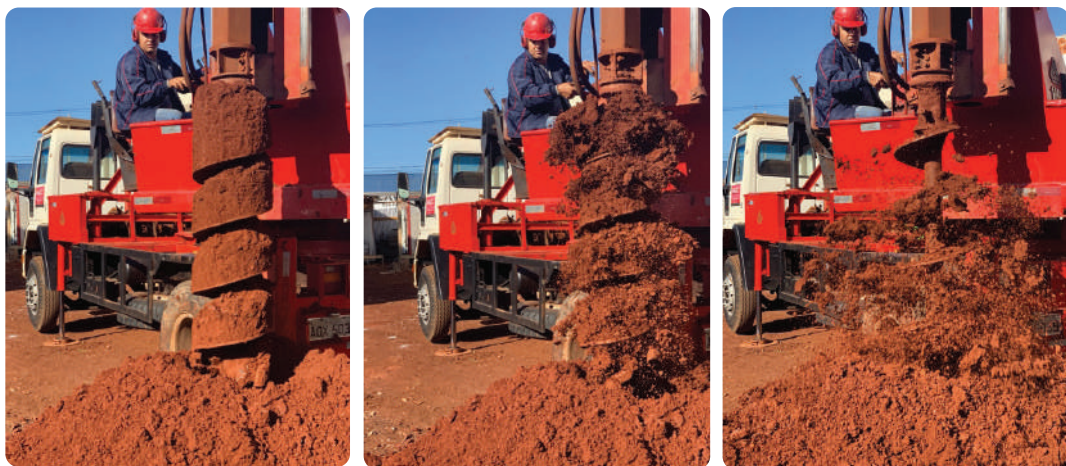
Figura 7.6 – Perfuração da estaca escavada. .
