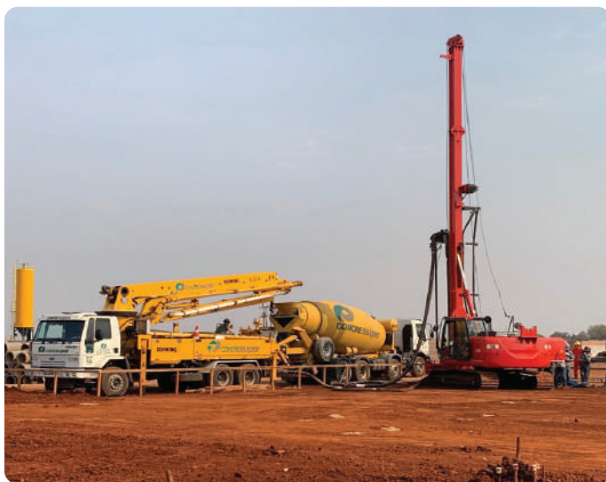
Figura 7.18 – Perfuratriz, bomba de concreto e caminhão betoneira.
