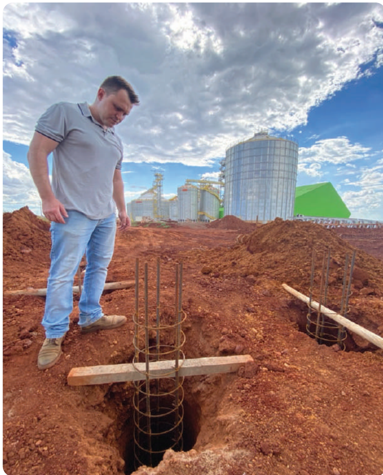
Figura 7.8 – Armaduras de estaca escavadas amarradas na cota do terreno.
